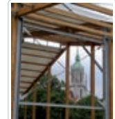
Arriostamiento en cruz de San Andrés. 29 Observa los dos cables que se cruzan en la estructura. ¿Qué crees que le aportan?
