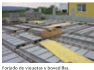
Forjado de viguetas y bovedillas.
