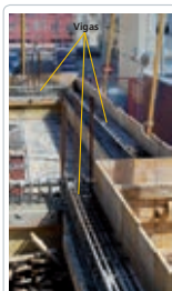
El hormigón necesita un molde hasta que se endurece (o fragua). Ese molde, que luego se retira, se denomina encofrado.
