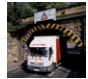
El gallobo indica la distancia mínima de paso que deben permitir los túneles, puentes y demás estructuras.
