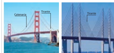
Puente colgante de catenaria.
