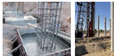
Cimentación con zapatas.
