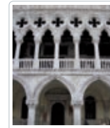
Fachada del palacio Ducal de Venecia.
