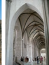
Bóveda de crucería.
